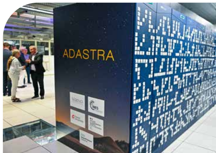
Dans les locaux du CINES à Montpellier.
