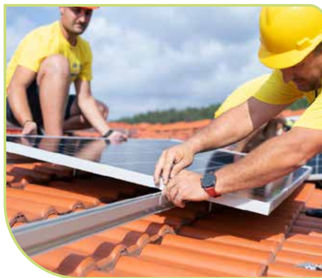
Pose de panneaux photovoltaïques ©Région Occitanie
